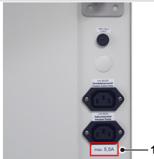
Abb. 13: Angabe des Maximalstroms für die Vakuumpumpe (Beispiel)
